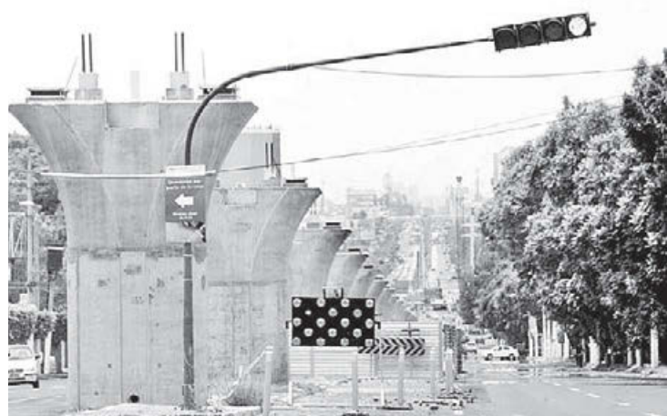
En las obras de la L3 los semáforos complican el tránsito
