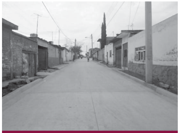
Término de obra de pavimentación de calles con recursos del Fondereg
